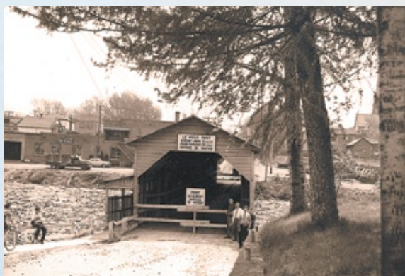
Le pont couvert en juin 1957, avant sa démolition, du côté de la rive ouest; remarquez le flottage du bois sur la rivière (Archives de la Ville de Saguenay)
