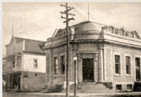
Ancien bureau de poste (construit en 1914) vers 1940, remplacé en 1955 par l'Édifice du gouvernement fédéral (BAnQ, collection numérique, cp 888)
