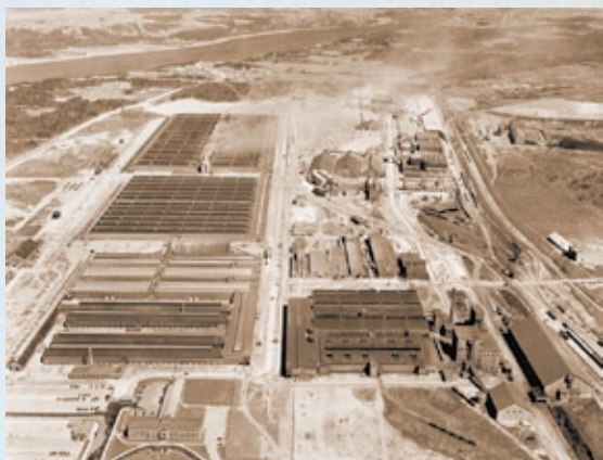
Usine Alcan d'Arvida, vue aérienne, vers 1945 (SAS, SHS, fph 132, album 1, p. 5)
